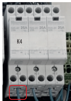
Rys. 93. Podłączenie pompy obiegowej za wymiennikiem płytowym
