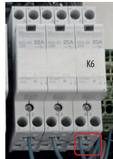
Rys. 95. Podłączenie pompy zaworu mieszającego 2
