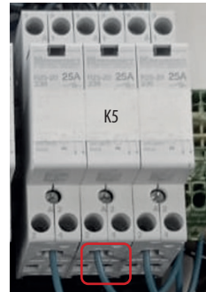
Rys. 94. Podłączenie pompy zaworu mieszającego 1
