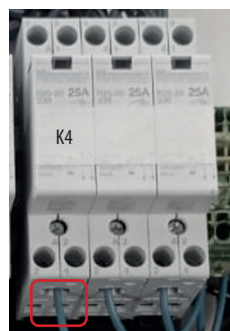
Rys. 93. Podłączenie pompy obiegowej za wymiennikiem płytowym
