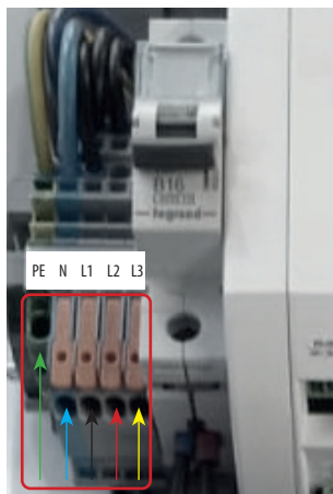
Rys. 88. Podłączenie zasilania Gbox 400 V (3 fazy)
