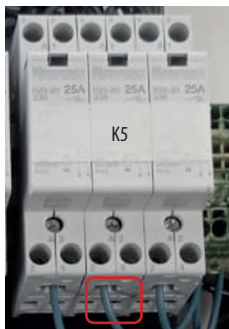
Rys. 94. Podłączenie pompy zaworu mieszającego 1
