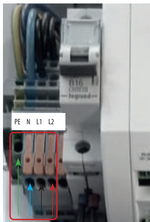
Rys. 89. Podłączenie zasilania Gbox 400 V (2 fazy)
