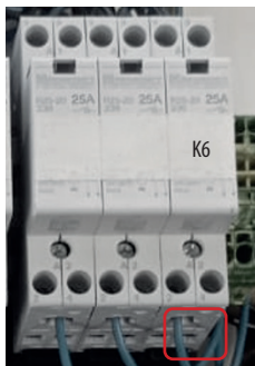
Rys. 95. Podłączenie pompy zaworu mieszającego 2
