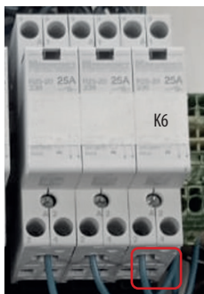
Rys. 95. Podłączenie pompy zaworu mieszającego 2
