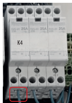
Rys. 93. Podłączenie pompy obiegowej za wymiennikiem płytowym
