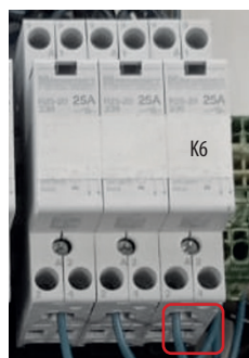
Rys. 95. Podłączenie pompy zaworu mieszającego 2
