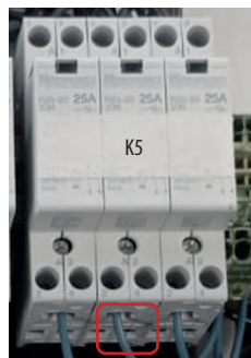
Rys. 94. Podłączenie pompy zaworu mieszającego 1
