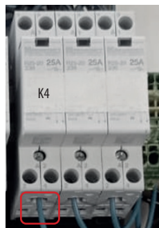
Rys. 93. Podłączenie pompy obiegowej za wymiennikiem płytowym
